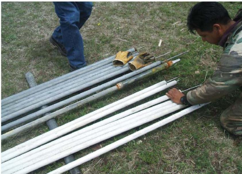
安装和维护期间，保护水泵和下降的管道，保持其不与地面直接接触
